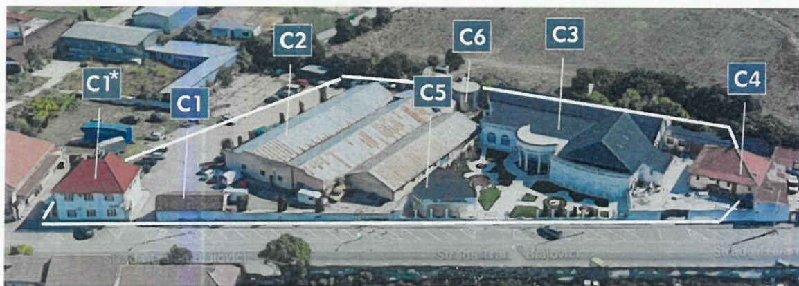
Vedere de ansamblu aeriana ale imobilelor apartinand proprietatii analizate
