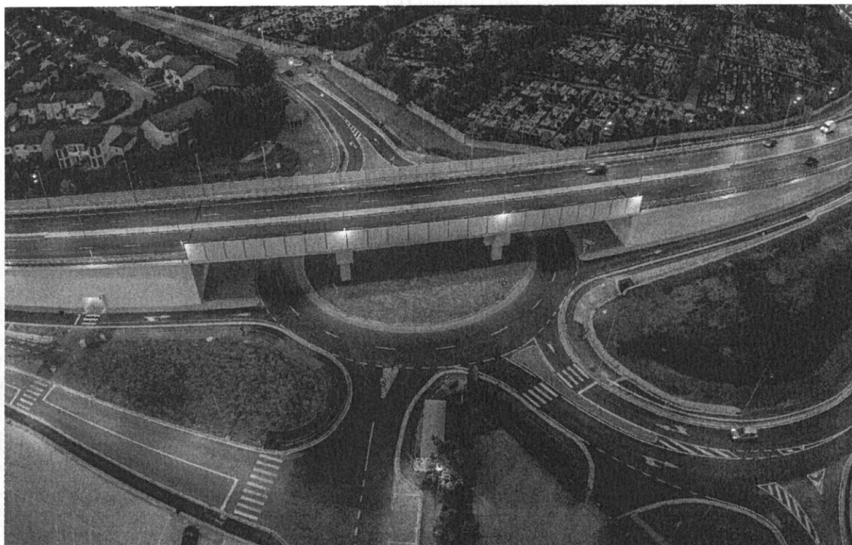
FIG.4.Amenajare intersecție prin pasaj denivelat între drumul de centură al Municipiului Oradea și Str. Universității (d)
