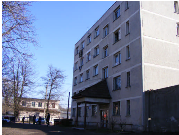
CCT 1 – strada Octavian Goga situația inițială
