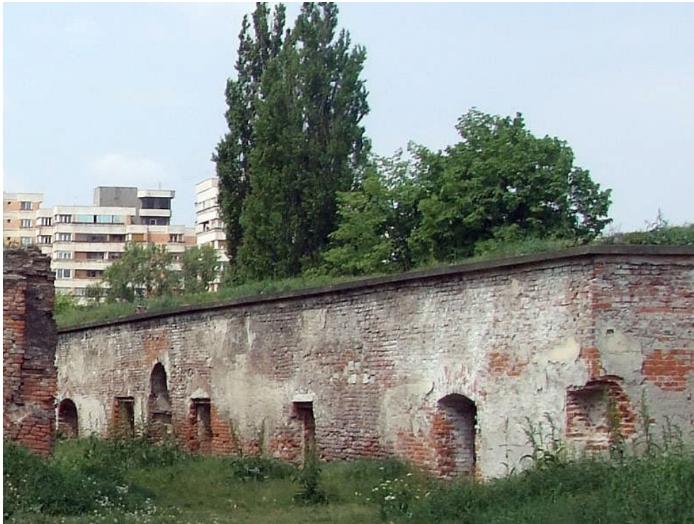
Corp L – Strada Breslelor - 2010
